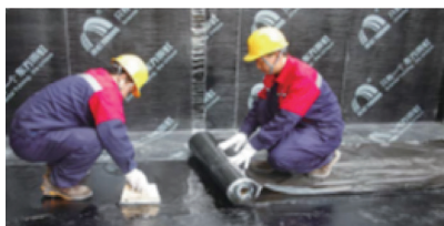
图4 人工刮涂施工
