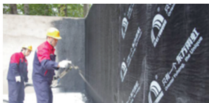
图5 机械喷涂施工
