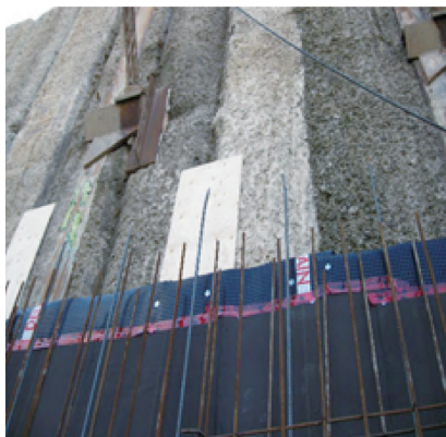
图2 侧墙施工
