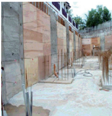
图2 侧墙施工
